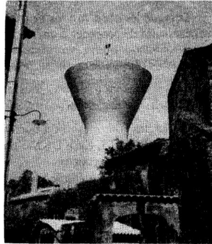
Mire sur château d'eau.
