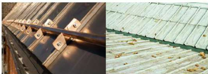
▶ Toiture en cuivre (à gauche) et toiture oxydée avec vert-de-gris ou hydroxycarbonate de cuivre \text{Cu}_2(\text{OH})_2\text{CO}_3 (à l'avant).
