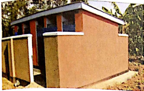
Fig 1 : des latrines à la disposition de la communauté
