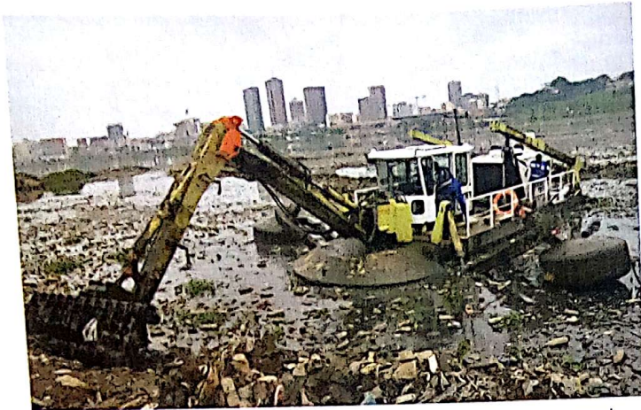
Une phase de l'aménagement de la baie de Cocody au niveau de la lagune Ébrié.
