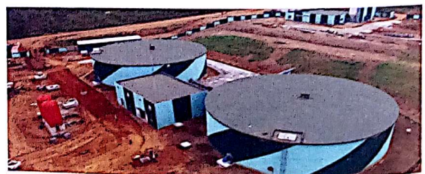
La station de traitement d'eau potable à Songon
