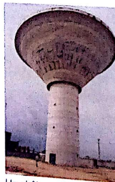
Un château d'eau
