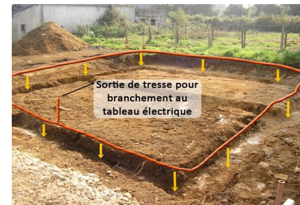
Technique de prise de terre par boucle
