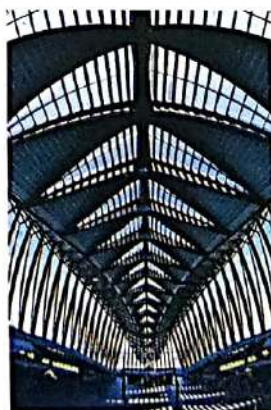
La gare TGV de l'aéroport de Lyon : la toiture inclinée est découpée en rectangles...
