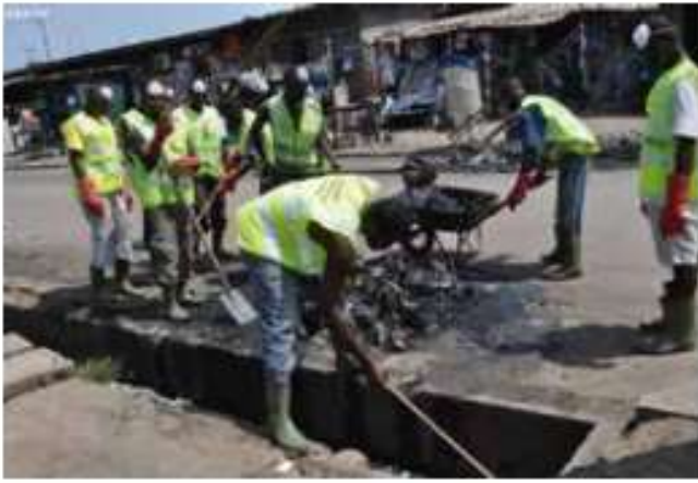
Figure 1 : Curage de caniveaux
