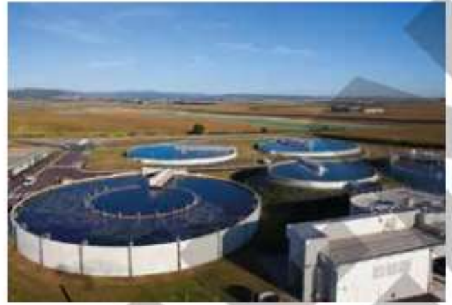
Figure 2 : Station de traitement des eaux usées
