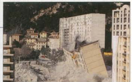
FIG. 3 Les explosifs sont utilisés pour détruire des immeubles ; la réaction chimique de décomposition est pratiquement instantanée.
