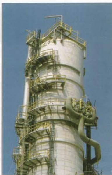
Fig. 7 Une tour de distillation du pétrole ; elle fournit des coupes de pétrole.
