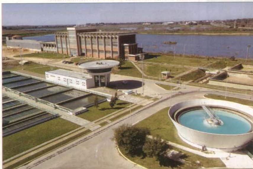
FIG. 13 Cette usine de traitement dépollue les eaux usées avant de les rejeter à la rivière.
