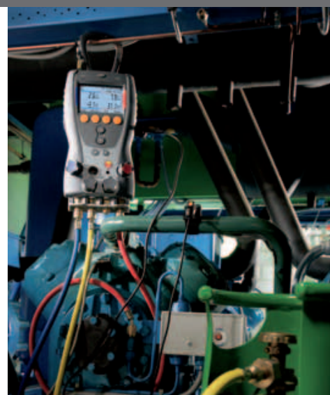
Le remplissage d'une installation via un testo 556/560
