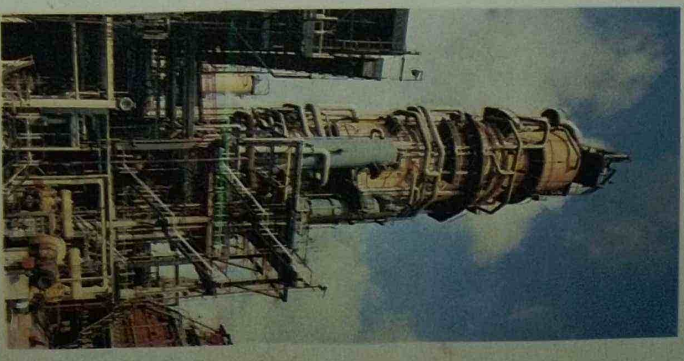
FIG. 19 a. Tour de distillation de pétrole. ▶ b. Tour de distillation en verre. ▶ c. Schema du plateau de distillation.
