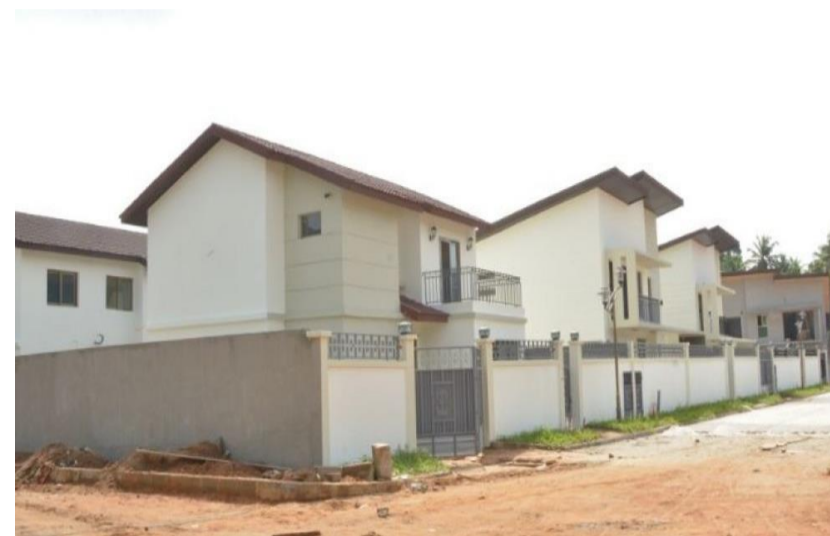
Photo 33: Logement social sur la route de Grand-Bassam
