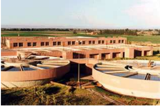
Station de traitement de Marrakech
