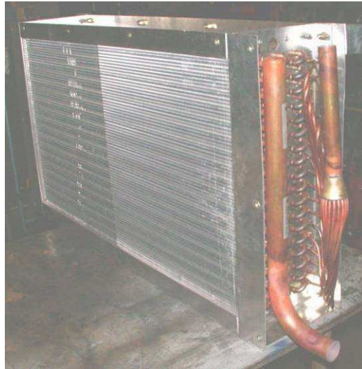
Figure III-10 Exemple de batterie à détente directe
