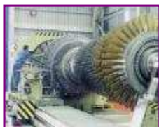
Turbine à gaz
