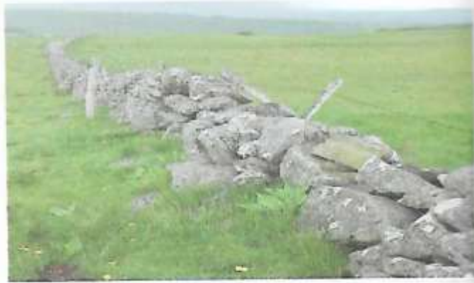
Figure 8 : Mur de pierres
