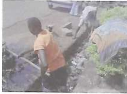
Nettoyage de caniveau
